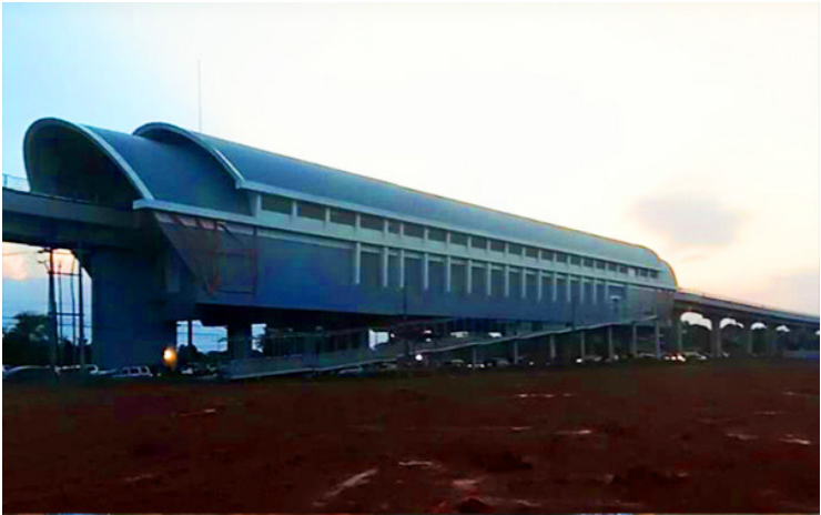
Stasiun LRT Jakabaring
